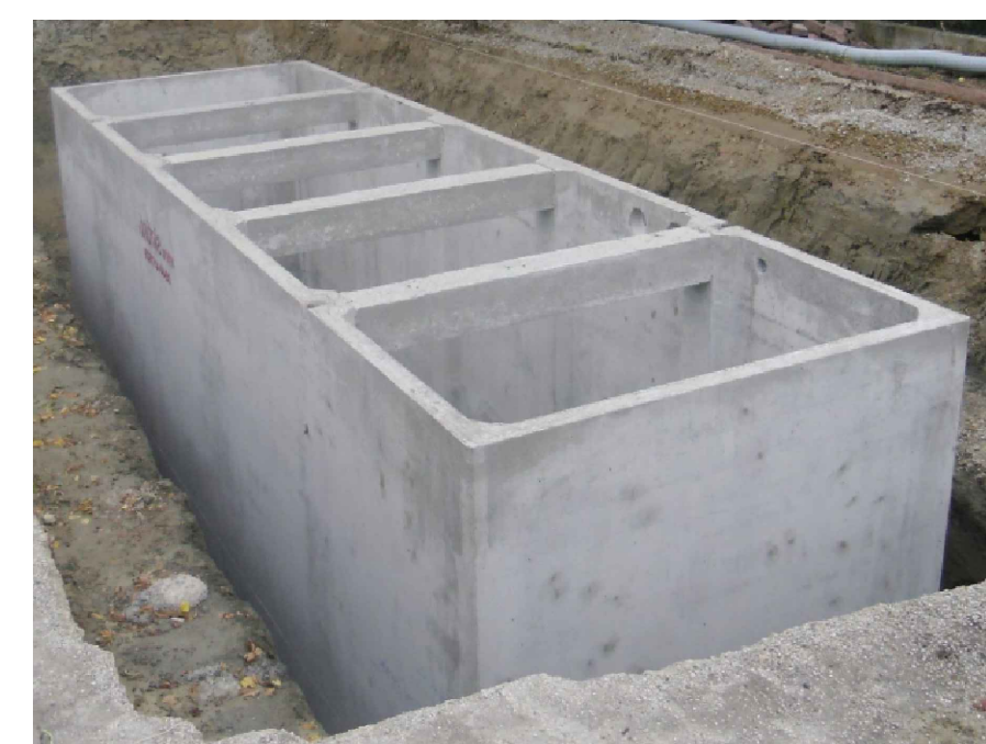
Filtro percolatore aerobico con pompa per il sollevamento del refluo in uscita
