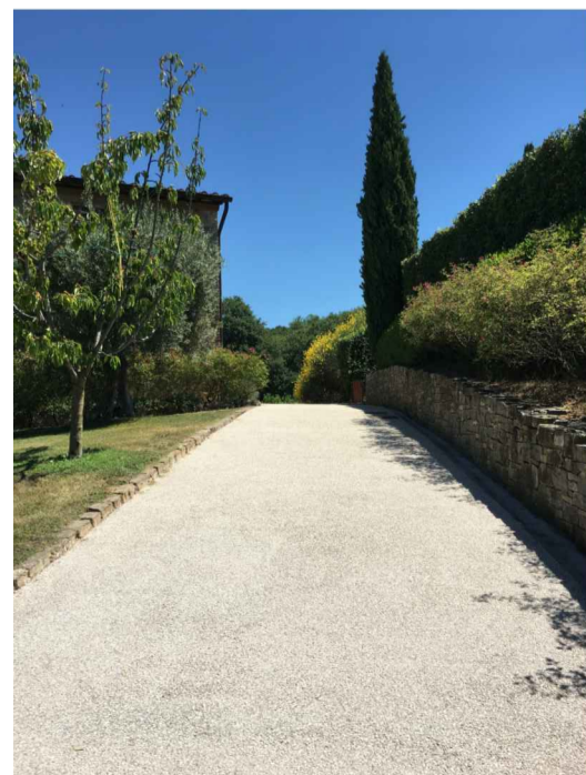
pavimentazione in calcestruzzo drenante DRAIN CALTIBER
