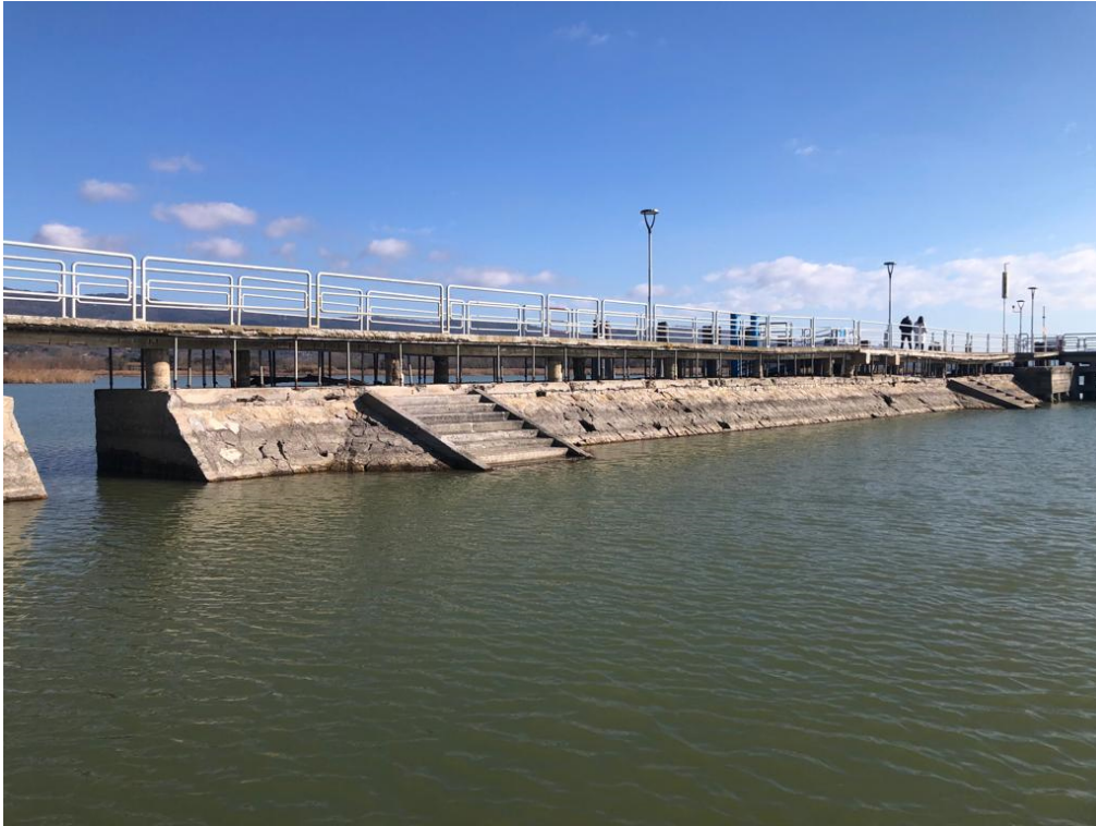
FOTO 1 - VISTA LATO NORD-OVEST
