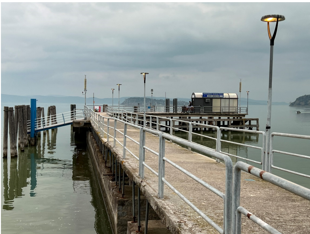
FOTO 4 - VISTA LATO SUD-EST
