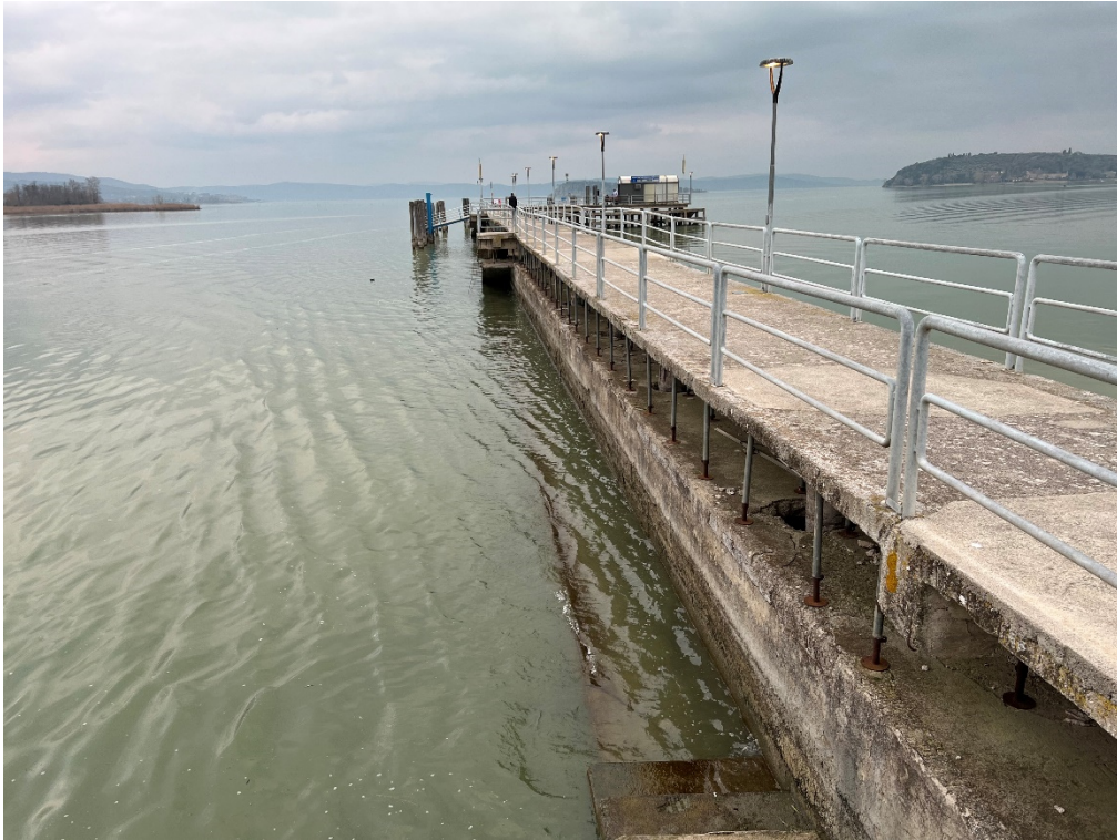
FOTO 3 - VISTA LATO SUD-EST
