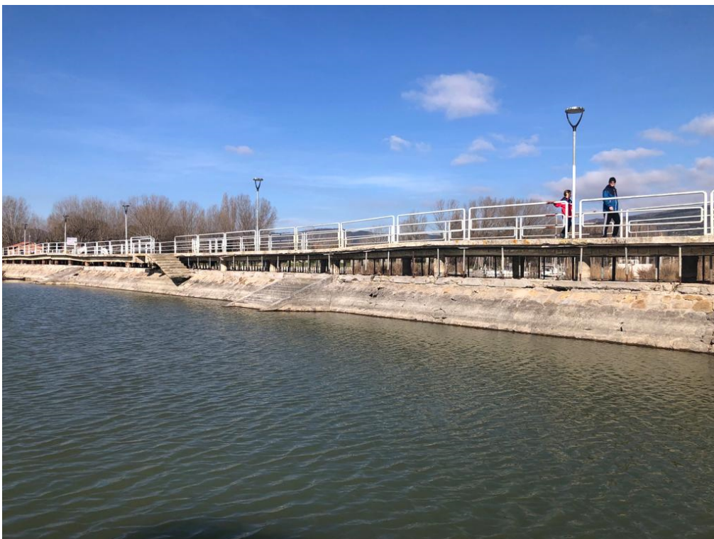
FOTO 2 - VISTA LATO NORD-OVEST
