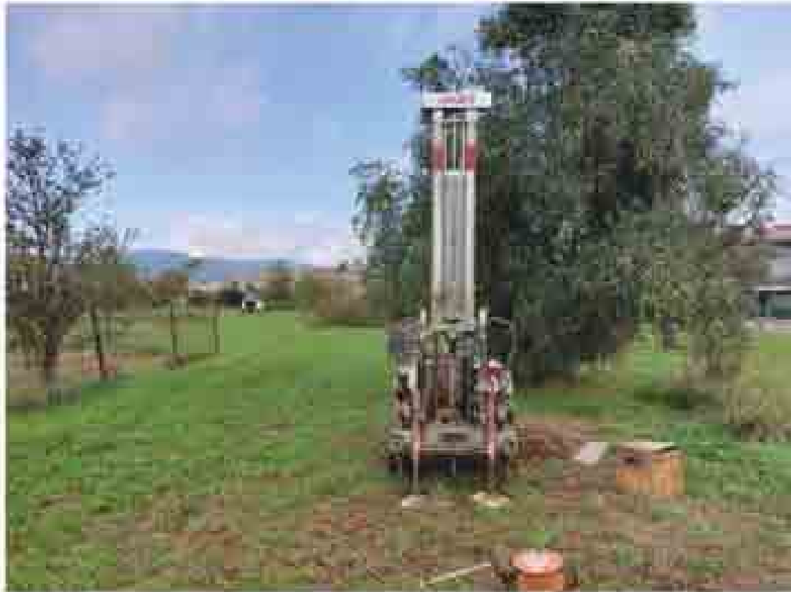
FOTO 1: Strumentazione utilizzata per l'esecuzione della prova CPT 4.
