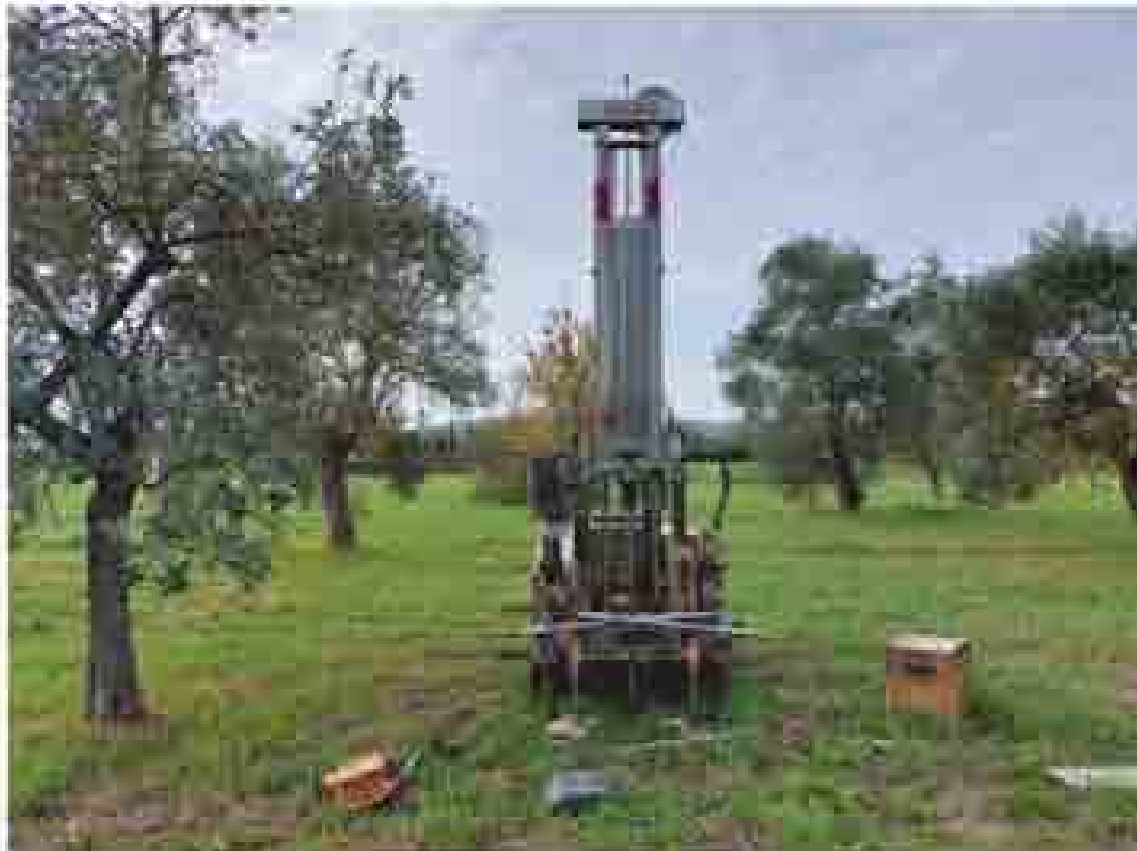
FOTO 1: Strumentazione utilizzata per l'esecuzione della prova CPT 3.
