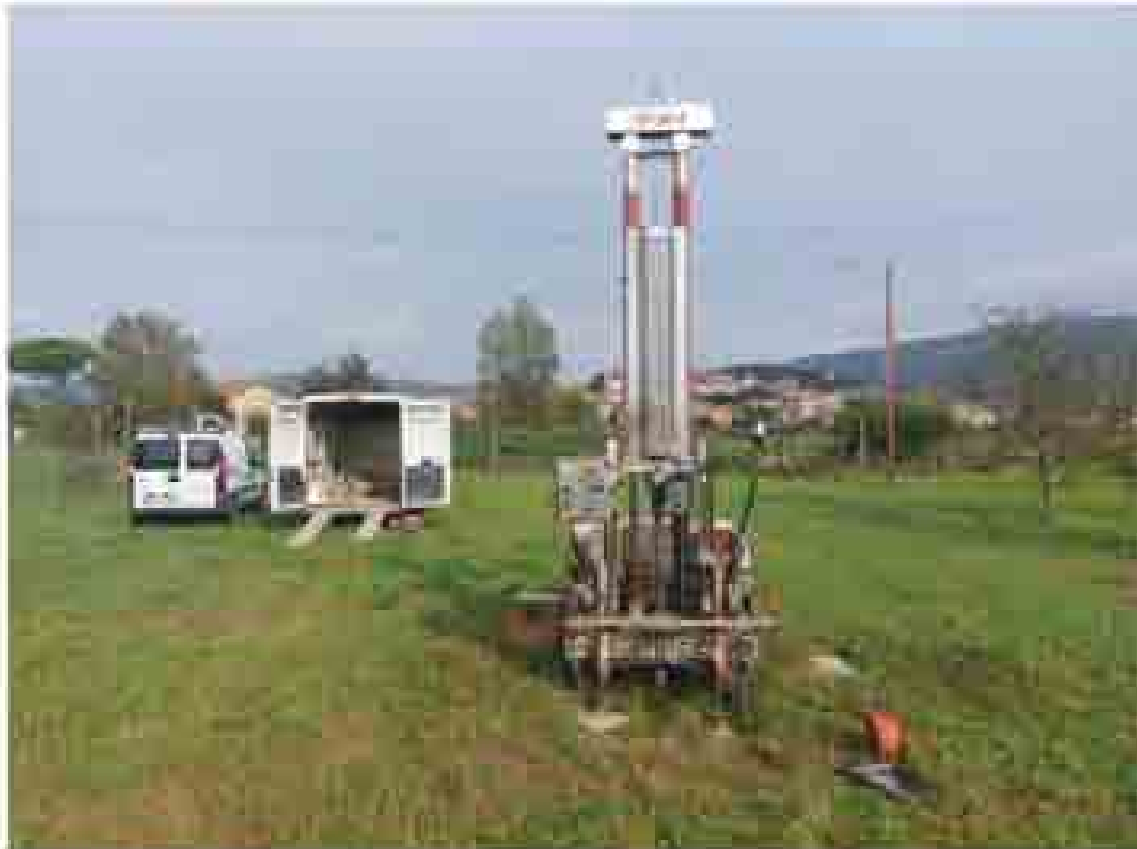
FOTO 1: Strumentazione utilizzata per l'esecuzione della prova CPT 1.
